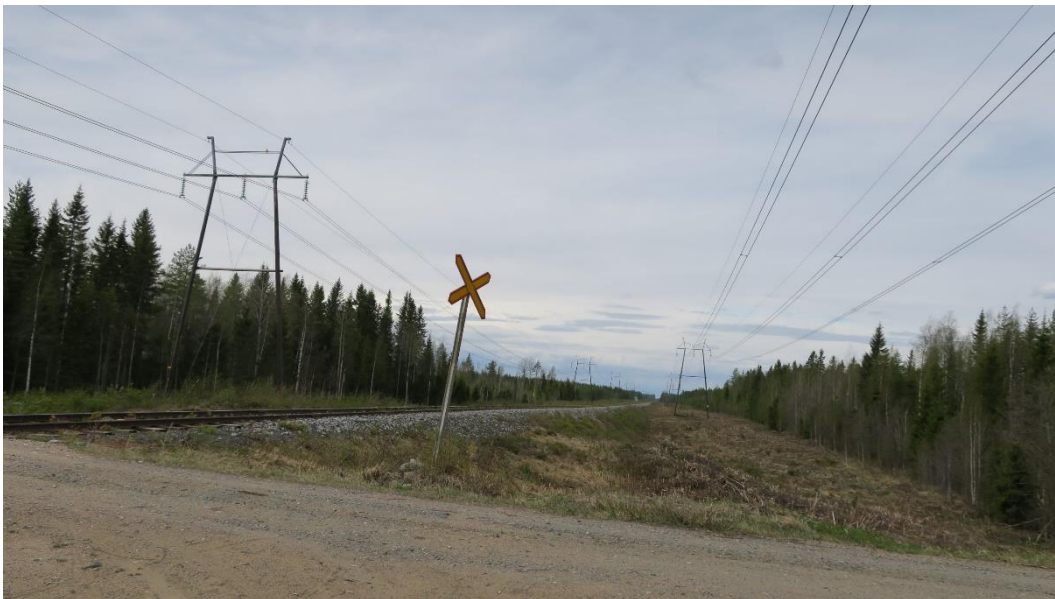
Kuva 7-1. Reitin loppupäässä rautatien molemmilla puolilla sijoittuu nykyään 110 kV voimajohto.
